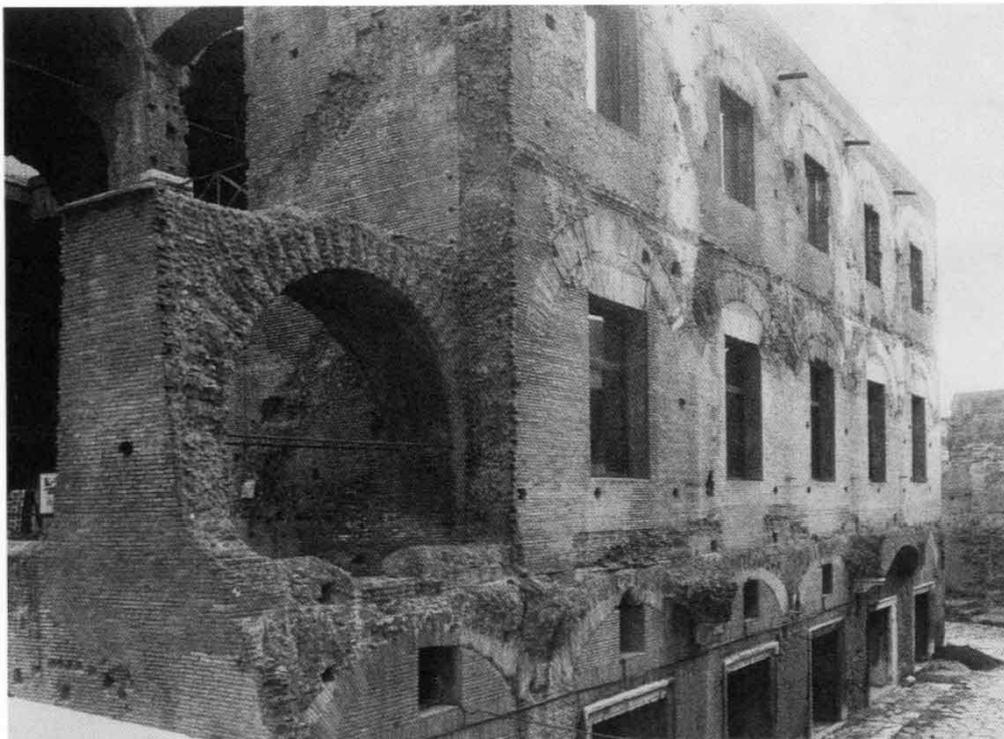
25. La volta di sostegno del pianerottolo ovest ricostruita nel 1930 (foto M. Bianchini).
