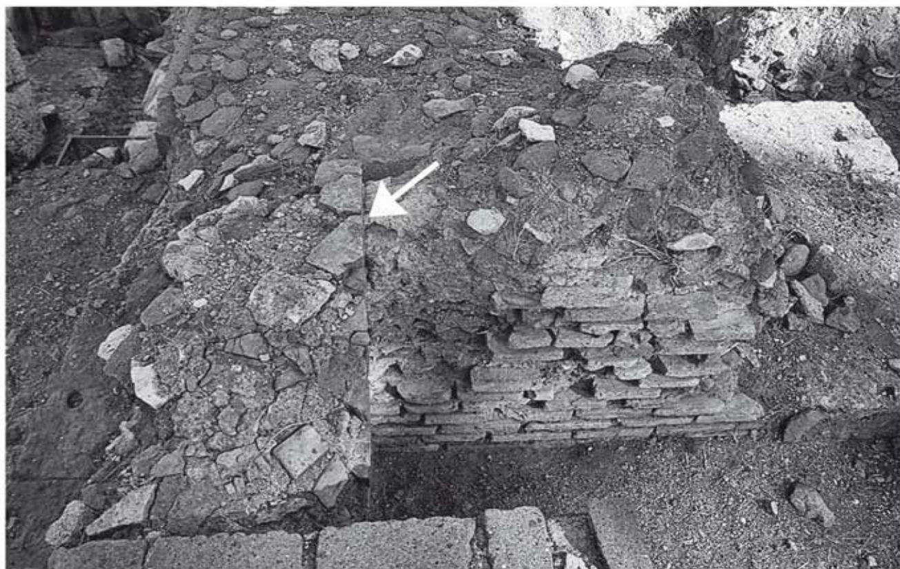
26. Particolare dell'accostamento tra l'ultimo bancone e la parasta (M. Vitti).
