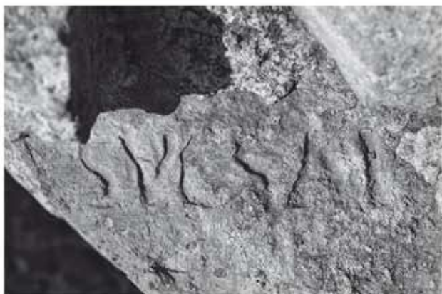
28. Bollo laterizio ( CIL , xv, 496) su di un mattone impiegato nella cortina della parasta (M. Vitti).
