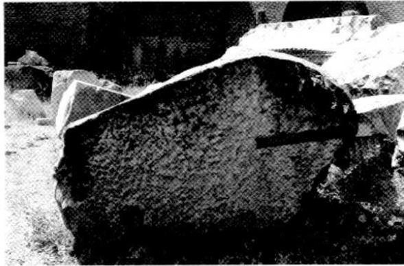
Fig. 5 Roma, Basilica Ulpia. Blocco di cornice con incasso per catena metallica.
