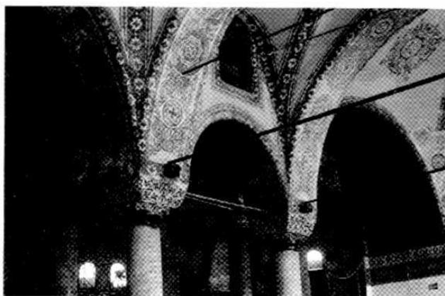
Fig. 11 Istanbul, Santa Sofia, matroneo, lato ovest. Tronconi dei tiranti lignei che collegavano i pilastri, sostituiti da quelli metallici. L'analisi al radiocarbonio del legname ha evidenziato una datazione al  $470 \pm 70$  del materiale; almeno alcune delle catene in ferro sono invece riferibili al restauro strutturale eseguito nel 1847-49 da Gaspare Fossati per il sultano Abdul Medjid.
