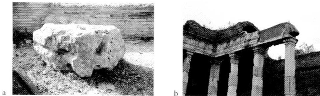
Fig. 4 Tivoli, Villa Adriana, Sala dei Pilastrini Dorici: a) particolare di uno dei pulvini in travertino; b) l'ornato architettonico della trabeazione in lastre di marmo applicate, che mostra la presenza di architravi, fodera le piattabande mascherandone la reale articolazione costruttiva, basata su un sistema spingente che permette di utilizzare pilastrini di sostegno estremamente snelli.
