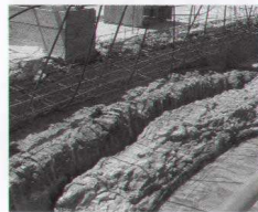
FIG. 2.49. Abside Nord, esterno. Ghiera in bipedali della direttrice dell'abside addossata, senza ammassature, alla ghiera, sempre in bipedali, della direttrice della volta a botte della corrispondente navata laterale.
