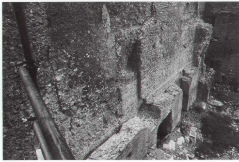
FIG. 2.9. Basilica, parete esterna Ovest, verso la via «ad Carinas». Muro perimetrale massenziano, senza cortina nella parte inferiore perché gettato utilizzando come struttura di contenimento i resti del muro flavio-romano degli Horrea Piperataria, poi livellati all'altezza del piano di calpestio della Basilica con la creazione di un terrapieno. In epoca medioevale parte del terrapieno è stato asportato per recuperare spazi utilizzabili, di cui rimangono le impronte delle testate dei muri trasversali e delle volte di copertura ricavate a scalpello nel muro massenziano.
