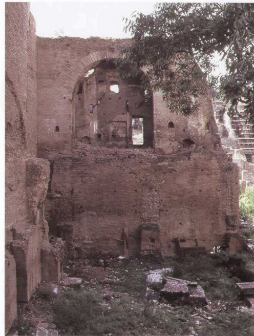
FIG. 2.18. Muro perimetrale Sud, lato interno. Visibili nella parte inferiore i resti dei pilastri in laterizio degli Horrea Piperataria, tamponati dalla muratura massenziana, originariamente nascosti dal terrapieno che uniformava il piano a quello interno della Basilica. In età medioevale quest'ultimo è stato vanificato per ricavare spazio utilizzabile, e l'area messa in comunicazione con il cd «portico medioevale» sulla via Sacra attraverso due varchi praticati nelle tamponature massenziane, ancora apprezzabili benché anch'essi successivamente risarciti.
