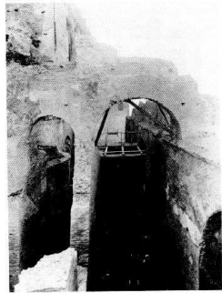
FIG. 2.56. Resti del muro di tramezzo e degli archi di contrasto, con ghiera in sesquipedali, da Est. A sinistra sono visibili le tracce lasciate dalla scala e dal relativo pianerottolo, addossata alla parete posteriore della piccola abside della Basilica, la cui finestra, tamponata, verrà liberata nuovamente. (Gab. Fotografico Comunale, Palazzo Braschi, inv. n. 1783)
