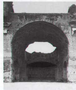
FIG. 2.50. Abside Nord, 1938, copertura provvisoria per consentire all'ambiente di ospitare un palco oratorio per Adolf Hitler, in visita a Roma. La finta volta è impostata all'altezza della trabeazione del colonnato architravato che schermava il muro di fondo, fornendo un'idea, anche se molto approssimativa, dell'aspetto complessivo dell'ambiente. Perfettamente visibili gli stipiti delle finestre del secondo ordine residue, contro cui era appoggiato l'arco che concludeva frontalmente il catino dell'abside. Lo squarcio nella calotta è documentato, con ampiezza via via crescente, fino dal XVI secolo; dallo stesso periodo risultano inutili, e poi murate, le finestre che illuminavano la navata, a causa dell'interro dell'intercapedine retrostante (Ist. Arch. Germanico, inv. n. 38/561).
