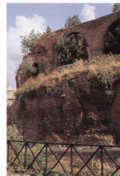
FIG. 2.4. Murature di sostruzione prevalentemente in opera cementizia di selce e travertino dello sbancamento neroniano della Velia, articolate in una doppia parete muraria, di cui l'esterna ad arcate in laterizio, intervallate da contrafforti a pettine. L'intera struttura, troncata a Nord-Ovest dalla costruzione della Basilica, ha subito modifiche ed adattamenti fino alla fine del 1700.
