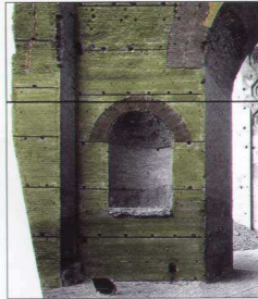
FIG. 5.5. Setto trasversale di sostegno di una delle volte a botte. La funzione di marcapiano del ricorso, in questo caso in rapporto all'imposta dell'arco che limita in alto la nicchia, viene comunque privilegiata quando non effettivamente coincidente con la posizione dei fori da ponte.
