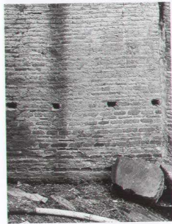
FIG. 5.11. Abside minore Nord, esterno: paramento in opera vittata ed in opera laterizia. All'interno la cortina non rispetta affatto la stessa partizione, ma ricorsi in tufelli interrompono la generale tessitura in laterizio. Una situazione analoga è riscontrabile nella parte alta del muro di contenimento della Velia, coevo, con cortina interna in vittato ed esterna in laterizio.
