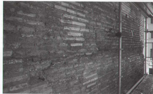
FIG. 5.31. Settore Nord Ovest, parete esterna. Disassamento di circa 2° rispetto all'asse longitudinale, poi corretto in corso d'opera a circa m 2,5 dal piano di calpestio interno della Basilica.
