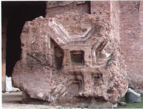
FIG. 5.17. Segmento di volta a crociera (n. 1 di Fig. 5.15), trovato al limite della campata centrale, e poi spostato in quella orientale in occasione della visita di Hitler nel 1938.
