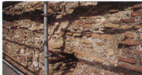
FIG. 5.29. Ogni apertura, risparmiata a partire dal piano di bipedali che marca il piano di spicco della volta a botte, è limitata in alto da due bipedali, e lateralmente da pareti in opera laterizia. A questo livello il conglomerato della volta è in opera cementizia con inerti prevalentemente di laterizio.
