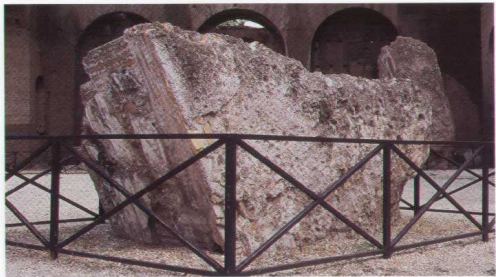
FIG. 5.22. Segmento di crociera (n. 2 di Fig. 5.15). In primo piano la sezione orizzontale dell'estradosso della volta, in conglomerato di tufo e scorie vulcaniche.
