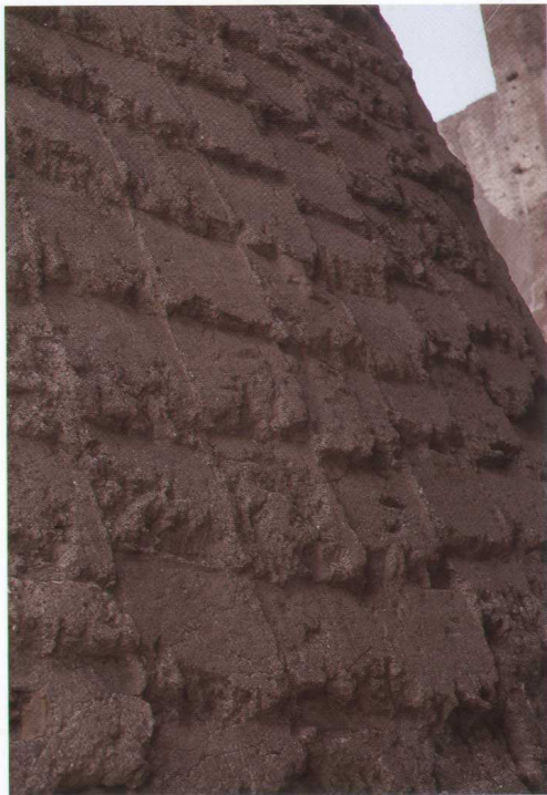
FIG. 5.19. Idem. Estradosso con impronta delle tegole (dim. 35x60) che ne definivano il manto terminale. Pertinente al limite esterno Nord della crociera centrale.
