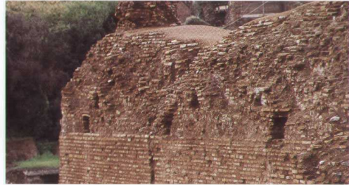
FIG. 5.28. Muro perimetrale Sud Ovest, lato interno. Visibili le aperture a sezione rettangolare lasciate in corso d'opera sulla linea d'imposta della volta, evidenziata dal marcapiano di bipedali. Gli incassi triangolari, che fornivano appoggio ai pali orizzontali della centina, sono stati rilavorati come elementi del cassettonato. Tasti effettuati sulla fascia d'imposta della corrispondente volta a botte del settore Nord Ovest hanno confermato una situazione identica; i fori sono chiusi in facciavista con malta e spezzoni di laterizio, e la superficie risultante intonacata in continuità con l'intero intradosso.
