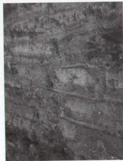
FIG. 5.12. Fodera del muro Est della Basilica, in rapporto agli adeguamenti effettuati in favore della Domus di età imperiale posizionata sulla Velia. Particolare della cortina muraria, con stirlatura e pozzolana bruna grigiastra.
