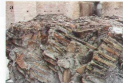
FIG. 5.20 Segmento di crociera (n. 2 di Fig. 5.15); pertinente al limite esterno Est della crociera orientale. Intradosso, vista generale e (a) particolare. Rispetto alla centina, le nervature di bipedali e di bessali sono disposte radialmente, mentre il riempimento è posizionato in parallelo. Rimangono tracce delle impronte delle tavole che costituivano il manto della centina, e della decorazione intradosale in stucco.
