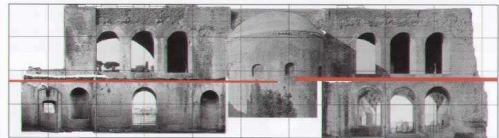
FIG. 5.39. Settore Nord Est, esterno, piano di appoggio del cornicione in laterizio, di andamento orizzontale, a sinistra dell'abside, è ad un livello inferiore di circa cm 40 rispetto a quello, di andamento leggermente in pendenza, a destra dell'abside. Lo sfasamento è stato risolto mettendo in opera nel segmento di destra lastre di lavagna di circa cm 1,5, e raccordando poi la tessitura del muro superiore con un ricorso di bipedali.
