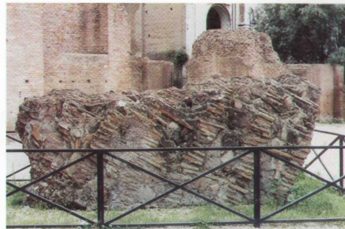
FIG. 5.20 Segmento di crociera (n. 2 di Fig. 5.15); pertinente al limite esterno Est della crociera orientale. Intradosso, vista generale e (a) particolare. Rispetto alla centina, le nervature di bipedali e di bessali sono disposte radialmente, mentre il riempimento è posizionato in parallelo. Rimangono tracce delle impronte delle tavole che costituivano il manto della centina, e della decorazione intradosale in stucco.
