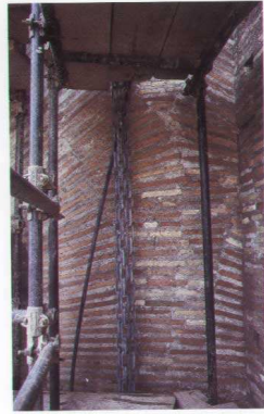
FIG. 5.36. Muro perimetrale Nord, tratto orientale. L'anomala tessitura delle ghiera degli archi delle nicchie nel segmento di raccordo con quelle degli archi dei finestroni ne suggerisce l'interpretazione come una modifica in corso d'opera rispetto al progetto originario.
