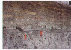
FIG. 5.38. Lato Nord, settore Ovest. Resti della cornice in lastre di lavagna, impostata sulla risega del muro perimetrale, qui a +11.28 QB.
