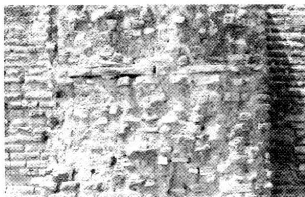
Fig. 5 Ostia, tessitura del nucleo di un pilastro di un caseggiato che si affaccia sul Decumano massimo.
