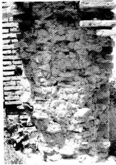
Fig. 6 Tessitura del nucleo di un muro di spina appartenente alla stessa fase ed allo stesso edificio della figura precedente.
