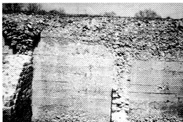
Fig. 8 Carsulac, cisterna in opus signinum gettato in cassaforma lignea.
