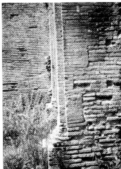
Fig. 4 Ostia, differenza tra la cortina di un portale con lesene (a sinistra) e la struttura del muro. Entrambe le cortine appartengono ad una stessa fase.
