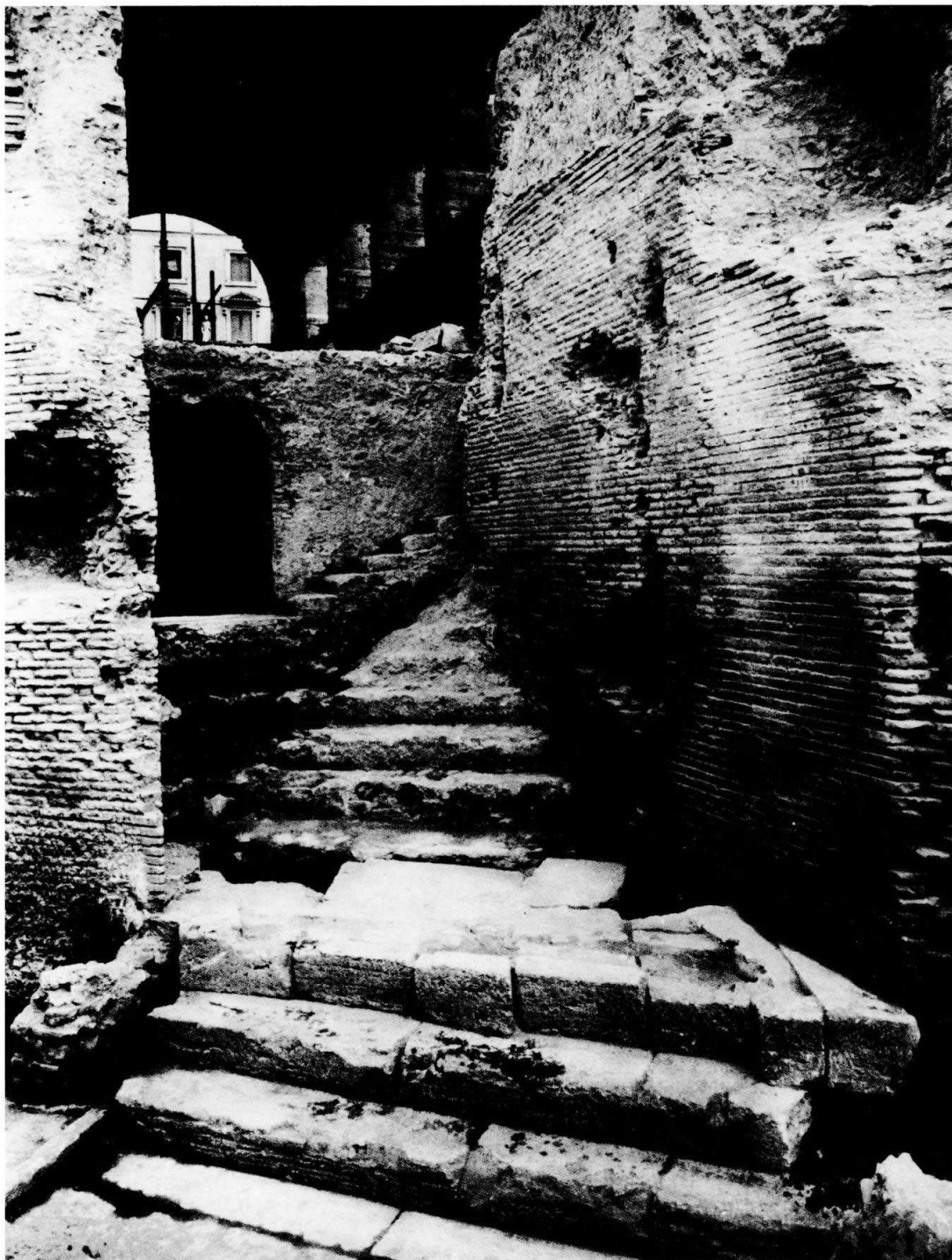
11. Grande Aula, fronte meridionale: in secondo piano la scala (ora obliterata) che collegava il pian terreno dell'Aula con le tabernae sottostanti (Gabinetto Comunale delle Stampe, Archivio Fotografico).
