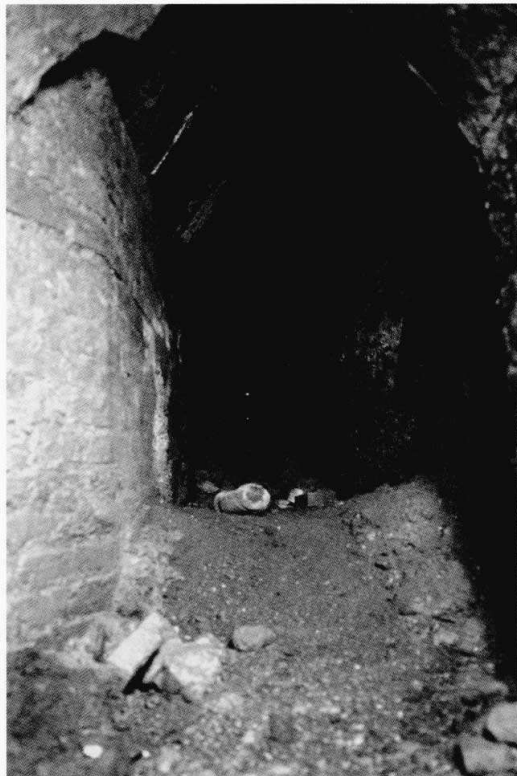
17. L'adduzione fognaria in corrispondenza della taberna 2 (foto M. Vitti).
