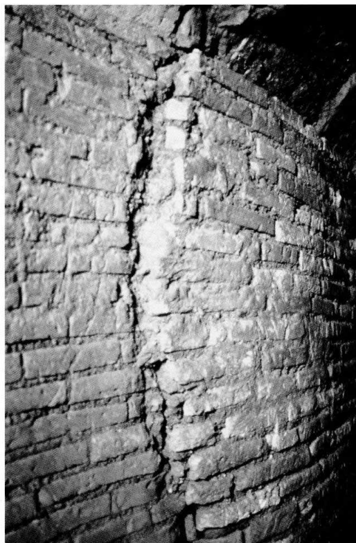
19. Veduta parziale del collettore principale della via Biberatica nel punto dove le spallette sono state rifoderate in cortina laterizia (foto M. Vitti).
