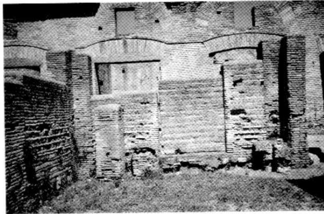
Fig. 2 Ostia, edificio commerciale della piazza dei Lari. Notare la progressiva riduzione delle luci e gli accentuati fuori piombo delle strutture.
