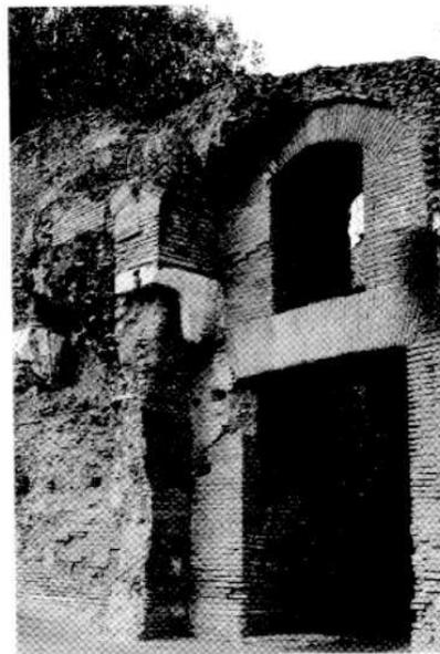
Fig. 3 Roma, edificio alle pendici del Palatino: consolidamento di un balcone retto da mensole.
