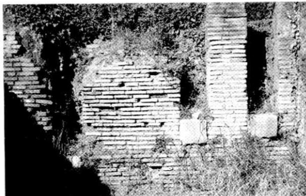
Fig. 6 Ostia, cosiddetto Mercato di via della Foce: alloggiamento dei pali con nucleo di appoggio in travertino.
