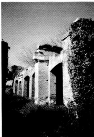
Fig. 4 Ostia. Caseggiato dei Misuratori di grano: il pilastro di sostegno svolgeva anche la funzione di piedritto dell'arco di contrasto.
