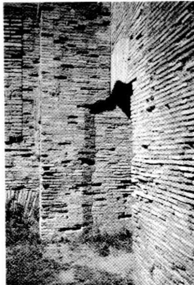
Fig. 11 Notare il bipedale posto in obliquo per sviare il carico.
