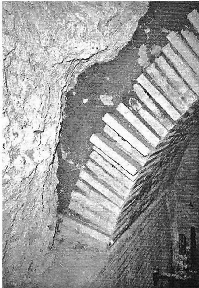
Fig. 14 - Domus Tiberiana. Settore 11, ambiente 14. Particolare della nervatura in prossimità dell'imposta della volta.
