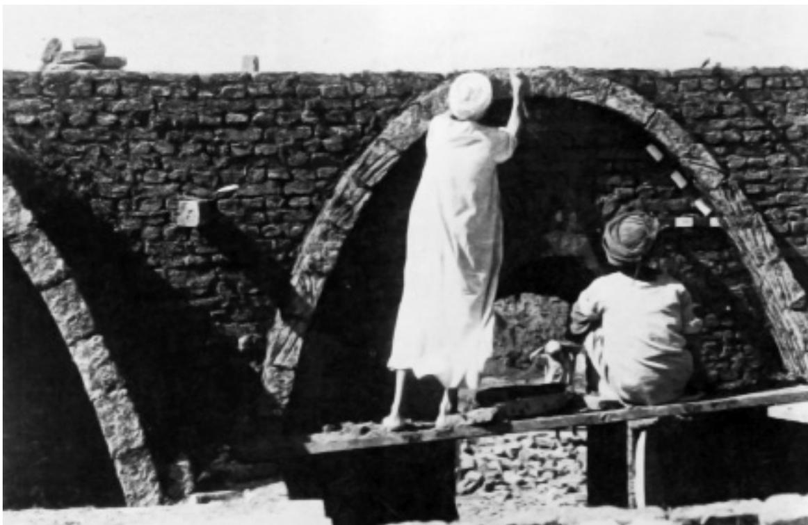
Fig. 29 - Un muratore mentre realizza una volta a mattoni affiancati di profilo parabolico. La costruzione procede frontalmente pressando i laterizi crudi contro l'argilla. Nella fase rappresentata i giunti fra un mattone e l'altro vengono riempiti, dopo la formazione dell'arco. Da notare l'assenza di centina. (da FATHY 1976, fig. 17).
