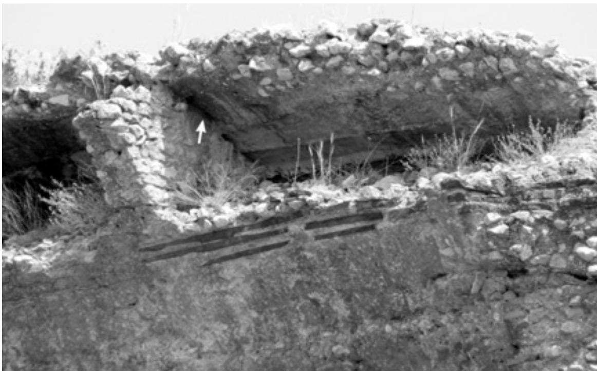
Fig. 23 - Particolare delle lastre di copertura in cementizio. Si notano le impronte del tavolato utilizzato come cassaforma. La freccia indica l'appoggio delle tavole sui frenelli. (foto dell'autore).
