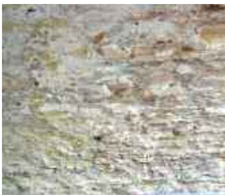
Fig. 6 – I caementa della volta: a sinistra il Tufo Giallo della via Tiberina, a destra i laterizi. (Archivio fotografico del Museo dei Fori Imperiali - M. Bianchini)
