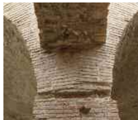
Fig. 7 – Ammorsatura delle ghiera degli archi di testata. (Archivio fotografico del Museo dei Fori Imperiali - S. Castellani)
