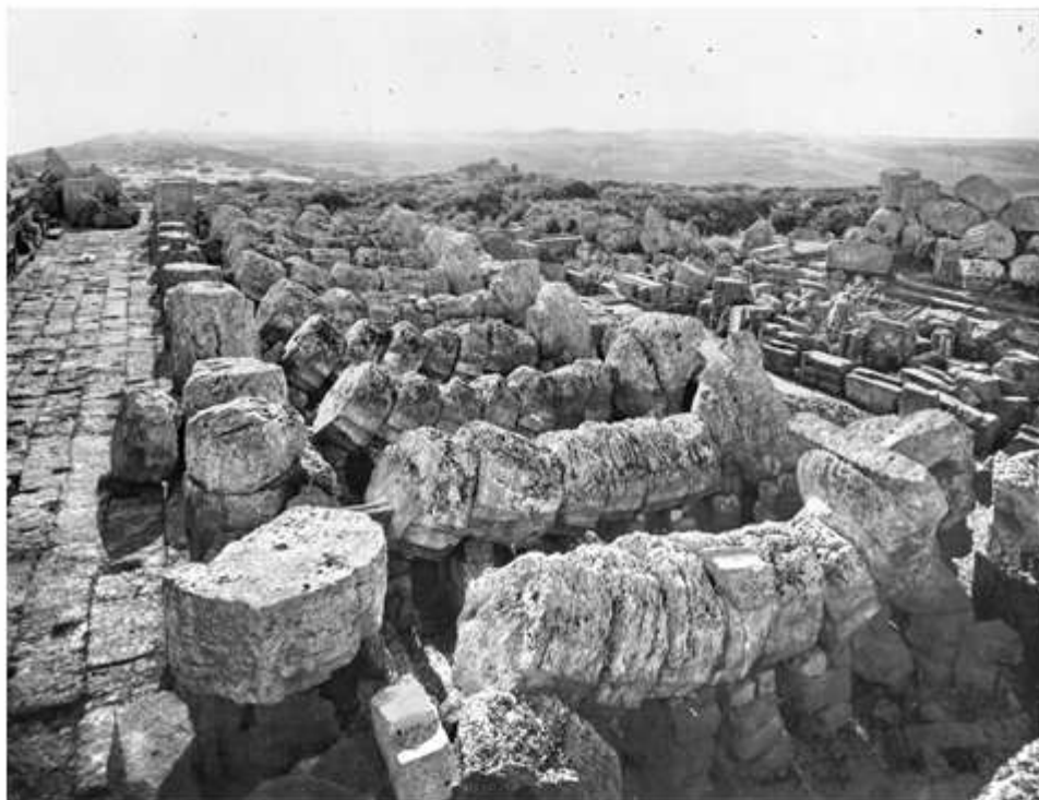
Fig. 1 - Selinunte, 1924. Colonne del lato nord della peristasi risistemate mantenendo la posizione di rinvenimento, in crollo da terremoto; poi rialzate nel 1925-26 insieme a parte della trabeazione pertinente (CICCD - Min.Beni Culturali ed Ambientali - Aerofototeca).
