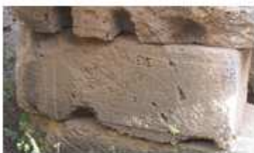
Fig. 31 - Alcuni dei blocchi pertinenti alla sommità del muro perimetrale della cella presentano sulla faccia vista verso la peristasi fasce perimetrali di cm 5 circa lavorate in sottosquadro, più spesso in senso orizzontale ma a volte anche verticale; con ogni probabilità superfici di riferimento per l'appiombamento e la corretta sovrapposizione dei vari elementi. I blocchi ancora in posto che costituiscono ciò che rimane dei muri perimetrali della cella 19 sono invece ben rifiniti, è probabile che non si fosse ritenuto necessario rilavorare gli elementi della parte alta perché comunque nascosti alla vista dal soffitto della peristasi.
