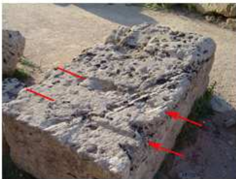
Fig. 14 a - Blocco superiore del geison BL5; in evidenza gli incassi per l'appoggio delle lastre della cassetta e della sima.
