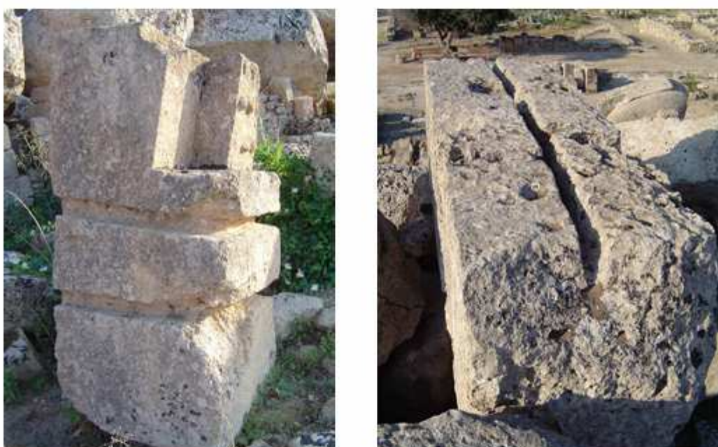
Fig. 12 a - Elemento del geison G57, non posizionabile con certezza, con solchi per l'inserimento delle corde per il sollevamento.
