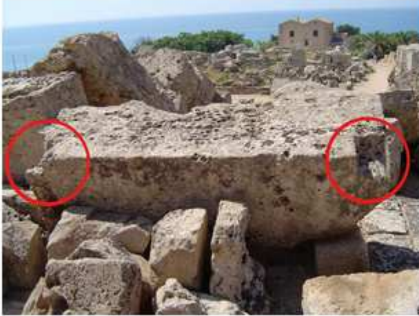
Fig. 10 - Architrave A8. In evidenza i due incassi per l'alloggiamento di travi, che trovavano riscontro con incassi speculari sui muri perimetrali della cella.
