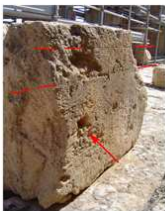
Fig. 7 a - Coronamento di architrave Aa 15, piano superiore, con linee guida per il posizionamento delle metope e dei triglifi, e incassi per le leve con cui facilitare la messa in opera dei blocchi del fregio.
