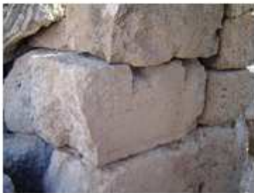
Fig. 30 - Blocco pertinente alla sommità del muro perimetrale della cella, con incassi per l'alloggiamento dei correnti obliqui, di cm 12 di ampiezza, posizionati a circa cm 20 di distanza. Sono identificabili con sicurezza soltanto venti blocchi analoghi, di altezza variabile tra i 39 ed i 52 cm, e di larghezza equivalente allo spessore del muro portante, cm 78 circa. In analogia, e probabilmente in connessione, con quanto documentato per i cosiddetti "terrakottatraegern", anche alcuni conci della sommità dei muri della cella hanno incassi per travature che si sovrappongono agli incassi dei correnti originali.
