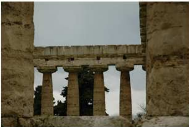
Fig. 11 - Paestum. Incassi analoghi ricavati sugli architravi della cosiddetta Basilica. A volte interpretati come pertinenti al soffitto della peristasi, per posizione, distribuzione e quota sono quasi certamente attribuibili ad apprestamenti di cantiere, in rapporto al sollevamento ed alla messa in opera dei blocchi, sia della parte restante della trabeazione della peristasi che dei muri della cella.
