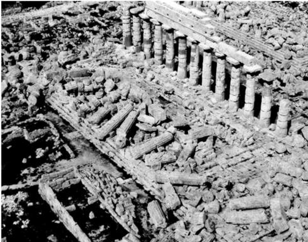
Fig. 3 - Selinunte, 1964. Veduta del Tempio C dopo l'anastilosi di 14 colonne e parte della relativa trabeazione. E' evidente l'obbligatorietà del ricorso al rilievo diretto per la realizzazione della planimetria generale (CICCD - Min. Beni Culturali ed Ambientali - Aerofototeca).
