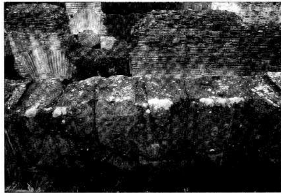
Fig. 14 Faccia superiore dei blocchi della prima fase con tre incassi a coda di rondine
