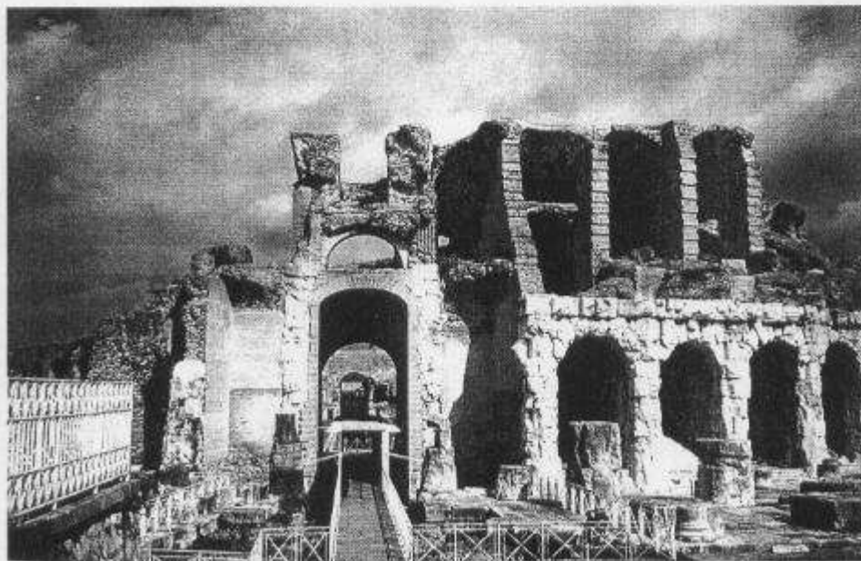
Fig. 4 – Ingresso meridionale: il fronte delle strutture conservate appartiene al lato settentrionale del II ambulacro e presenta evidenti danni del fuoco.
