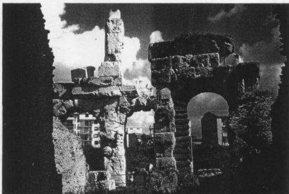
Fig. 5 – Veduta dall'interno. Si noti la differenza dello stato di conservazione del calcare scoperto (calcinato e fessurato) rispetto a quello che fu protetto dalla muratura (volta del I ambulacro e muro del cuneo nel pilone a ridosso dell'arco restaurato).
