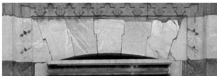
Fig. 34 – Siria, Fethiye Camii, piattabanda a saetta nell'architettura islamica.
