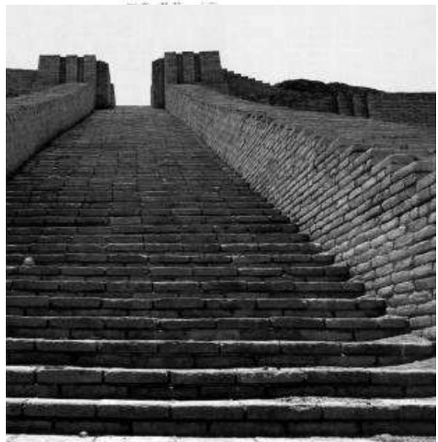
FIG. 120 - Ricostruzione della Ziggurat di Ur e particolare della scalinata di accesso in mattoni cotti (XXI sec. a.C.)
