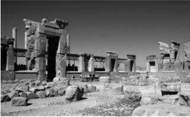
Fig. 216 - Persepolis. Sala delle Cento Colonne. Portali e nicchie di pietra del muro perimetrale. La restante struttura in mattoni crudi è andata perduta
