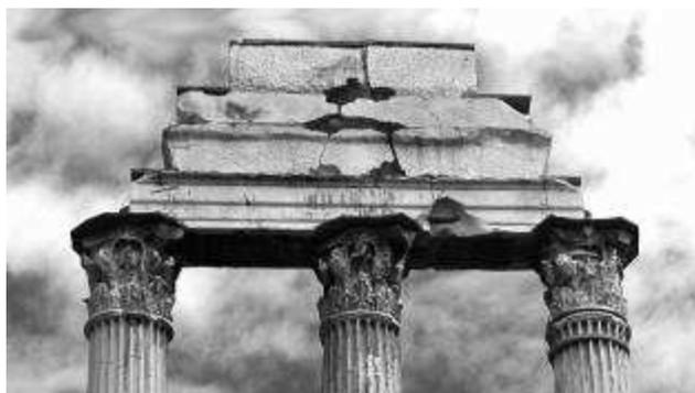
Fig. 364 - Roma. Tempio dei Castori. Fregio composto da conci a cuneo con funzione di piattabanda di scarico a protezione dell'architrave
