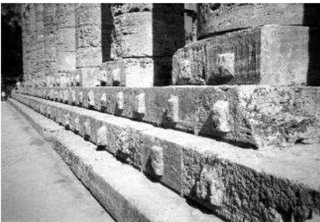
Fig. 183 - Tempio di Segesta (ultimo quarto del V sec. a.C.). Elementi distanziatori di forma troncopiramidale risparmiati sui blocchi della crepidine
