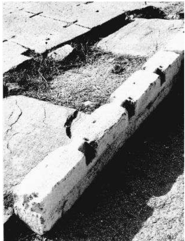
Fig. 339 - Delo. Stoa dei Nassi. Trave di colmo in marmo con gli incassi laterali per i puntoni
