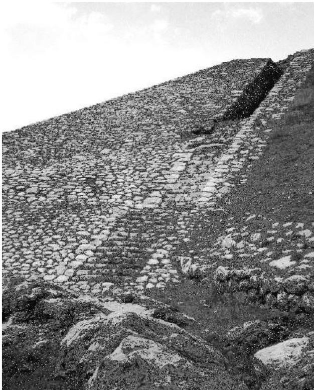
Fig. 236 - Hattusa. Rivestimento in blocchi di pietra dello spigolo meridionale del terrapieno (Yerkapi), all'esterno della cinta difensiva
