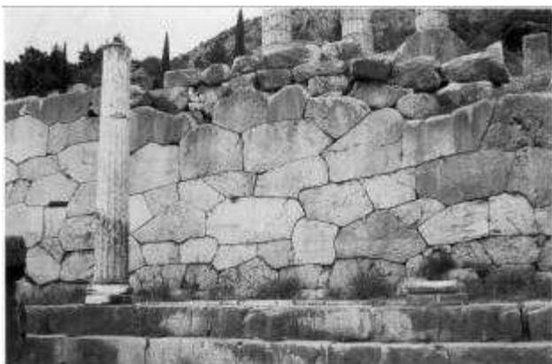
Fig. 248 - Delfi. Portico degli Ateniesi. Particolare del muro posteriore in opera lesbica, circa 480-470 a.C.
