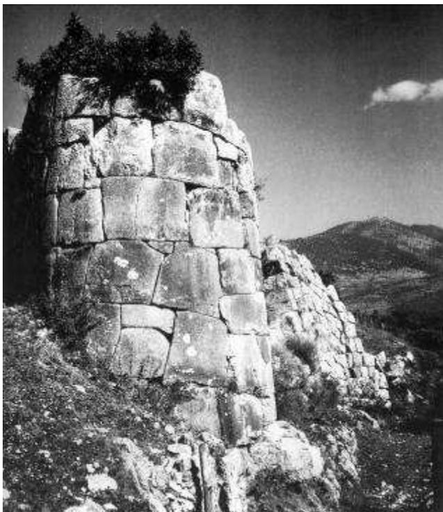
Fig. 260 – Norba. La torre semicircolare di Porta Maggiore in opera poligonale di IV maniera
