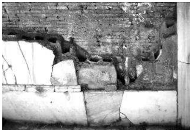
Fig. 626 - Ostia. Terme del Foro. Resti dei tubuli dell'impianto di riscaldamento e delle *crustae marmoreae* del rivestimento
