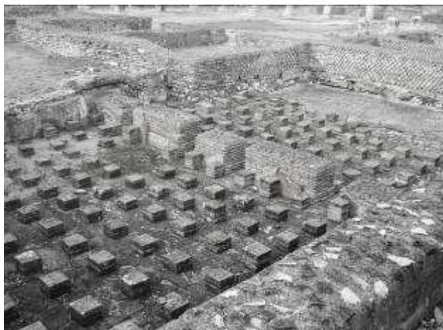
Fig. 625 - Minturno. Terme presso il *Macellum*. Resti dell'ipocausto di un ambiente a pianta rettangolare che è stato identificato con un *apodyterium*. L'ipocausto è diviso in due settori da un muretto trasversale (CIRIELLO 2010)
