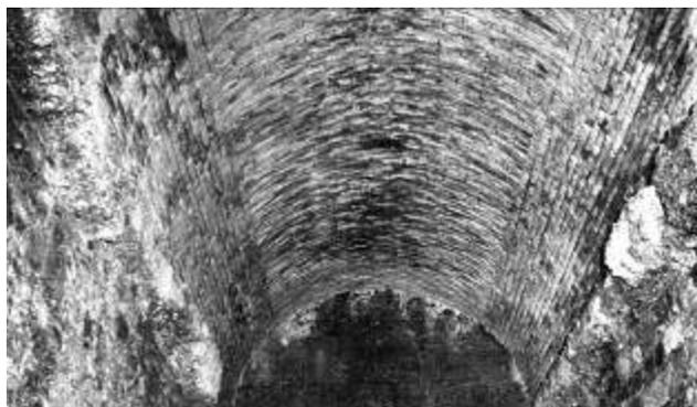
Fig. 578 - Aspendos. Sostruzioni della basilica. Volta a botte in mattoni. Gli anelli trasversali partono dalle reni.
