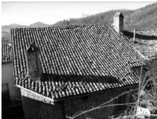
Fig. 159 – Tetti di Carsoli
