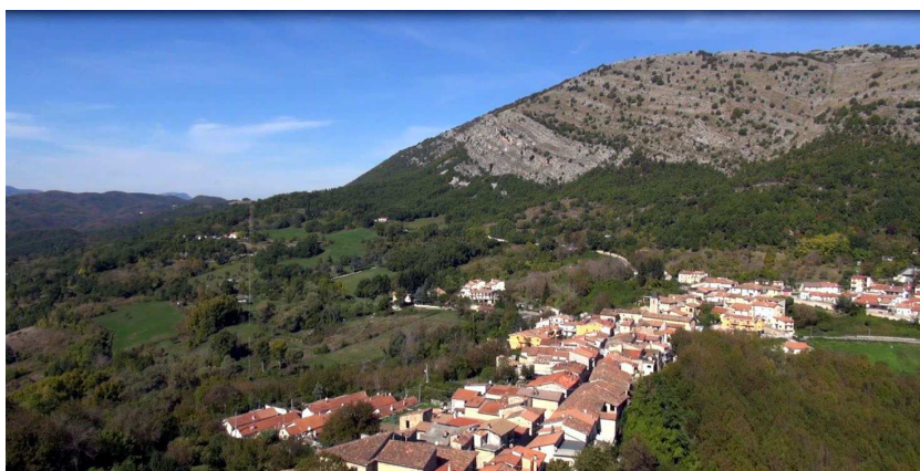
Figura 1 - Veduta aerea di Scanzano da sud, con lo sfondo del Monte Faito (1455 m)
