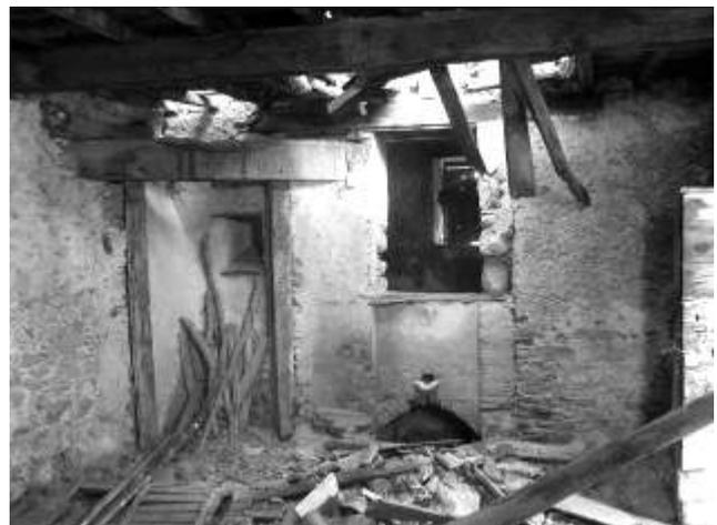
Fig. 197 – Casale a Fonte Scodella. Supefetazioni novecentesche sul lato SE della cucina: ripostiglio (a sinistra) e pozzetto per la raccolta del mosto (al centro in basso) prodotto nel vano retrostante
