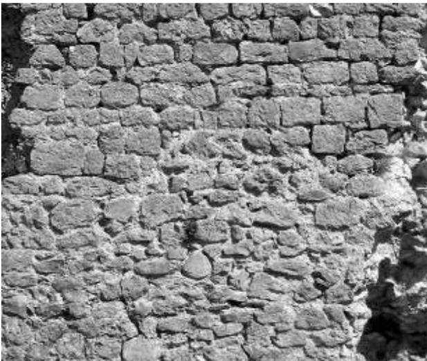
Fig. 61 – Castello di Tremonti. Torre centrale. Cortina del lato sud della torre. La muratura in blocchetti più regolari nella parte superiore appartiene a una fase successiva
