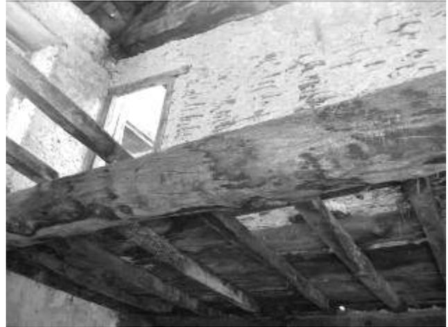
Fig. 196 – Casale a Fonte Scodella. Solaio tra primo e secondo livello sul quale è impostato un tramezzo in materiali leggeri (*fratticcio*)
