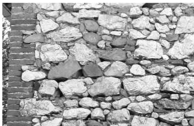
Fig. 257 – Sante Marie. Muratura di un casaleto sulle Serre, in prossimità del "Castiglione". Nella muratura le bianche pietre calcaree sono mescolate a pezzi di scura arenaria e frammenti di laterizi. I cantonali sono in mattoni
