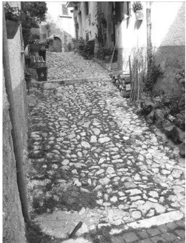
Fig. 157 – Pavimentazione in ciottoli in una stradina di Poggetello
