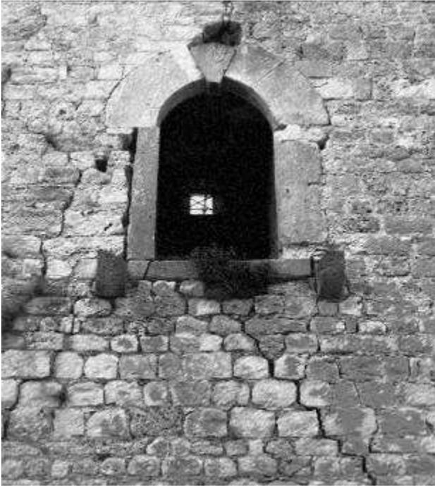
Fig. 60 – Castello di Torano. Muratura del lato N del Mastio. Il portale era accessibile tramite un ponte levatoio.
