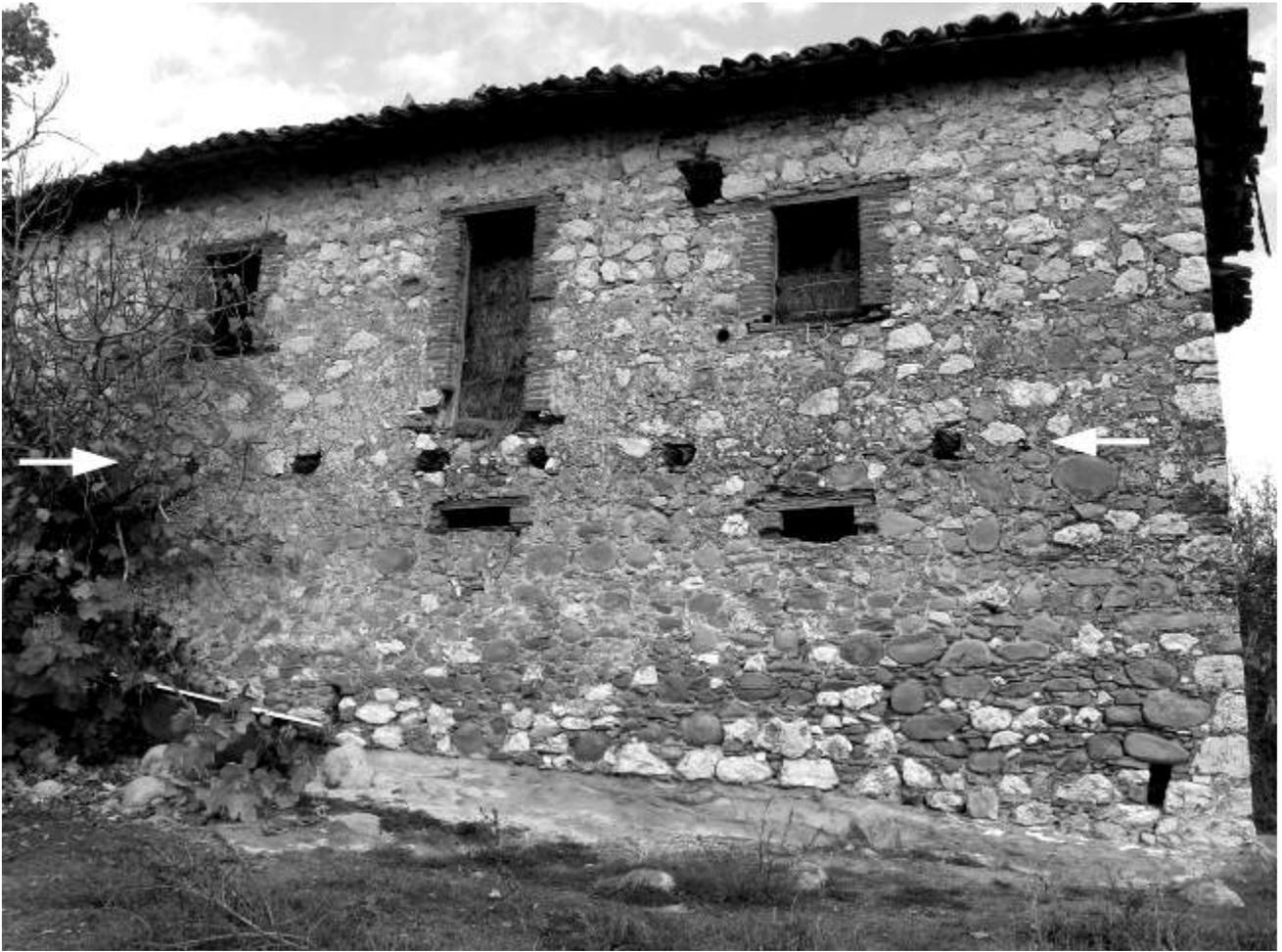
Fig. 267 – Boccalve (Sante Marie). Stalla-fienile. Le frecce bianche indicano le teste delle travi del solaio interno che fuoriescono dal muro
