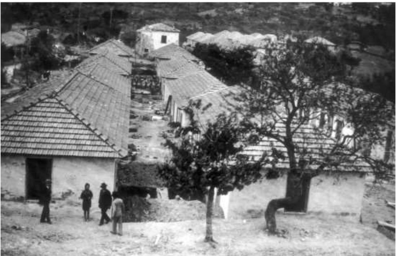
Fig. 313 – Complesso di casette asismiche di un paese marsicano in una foto d'epoca
