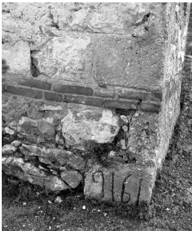
Fig. 263 – Poggetello. Particolare della stalla-fienile, con la data 1916 impressa su un blocco di cemento (rovesciato) alla base del muro
