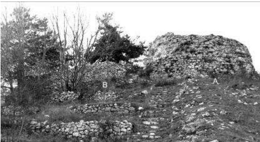
Fig. 103 – Castello di San Donato. Recinto superiore. Lato orientale. A. Torre circolare NE; B. Muro in pietra a secco di fase successiva
