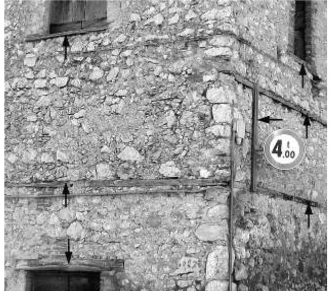
Fig. 260 – Sante Marie. Stalla-fienile all'incrocio fra via Roma e via San Quirico. Le frecce indicano gli elementi lignei inseriti nel muro: architravi, davanzali e catene. Quest'ultime sono collegate in qualche caso da ritti.
