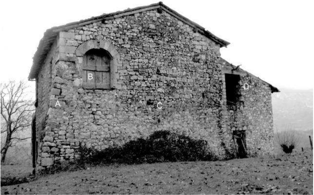
Fig. 141 – Scanzano. *Castejo*. Muro d'alzato, forse di epoca medievale, inglobato in un edificio più recente. A. Contrafforte d'angolo; B. Apertura ad arco ribassato; C. Doccione; D. Corpo di fabbrica addossato
