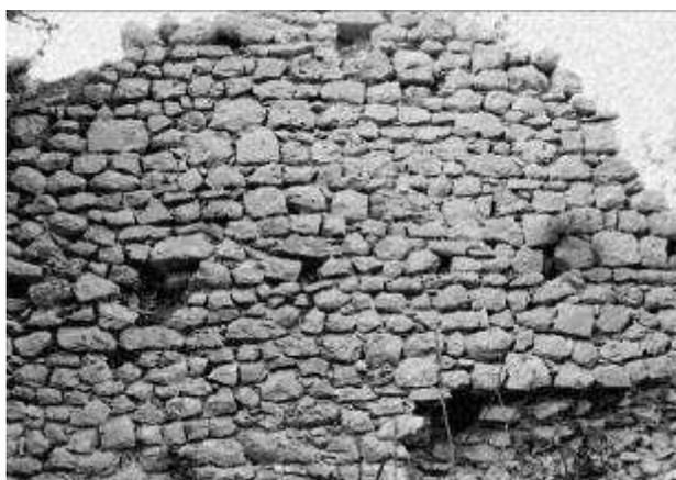
Fig. 64 – Castello di San Donato. Recinto superiore (A). Lato S del muro settentrionale. Sulla parete sono visibili i fori dei ponteggi
