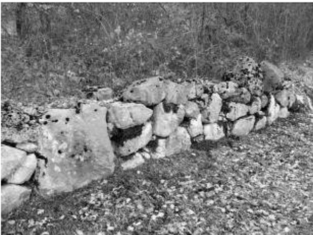
Fig. 41 - *Vicus* italo-romano di Colle Nerino. Muro di cinta SO in opera poligonale di I-II maniera.
