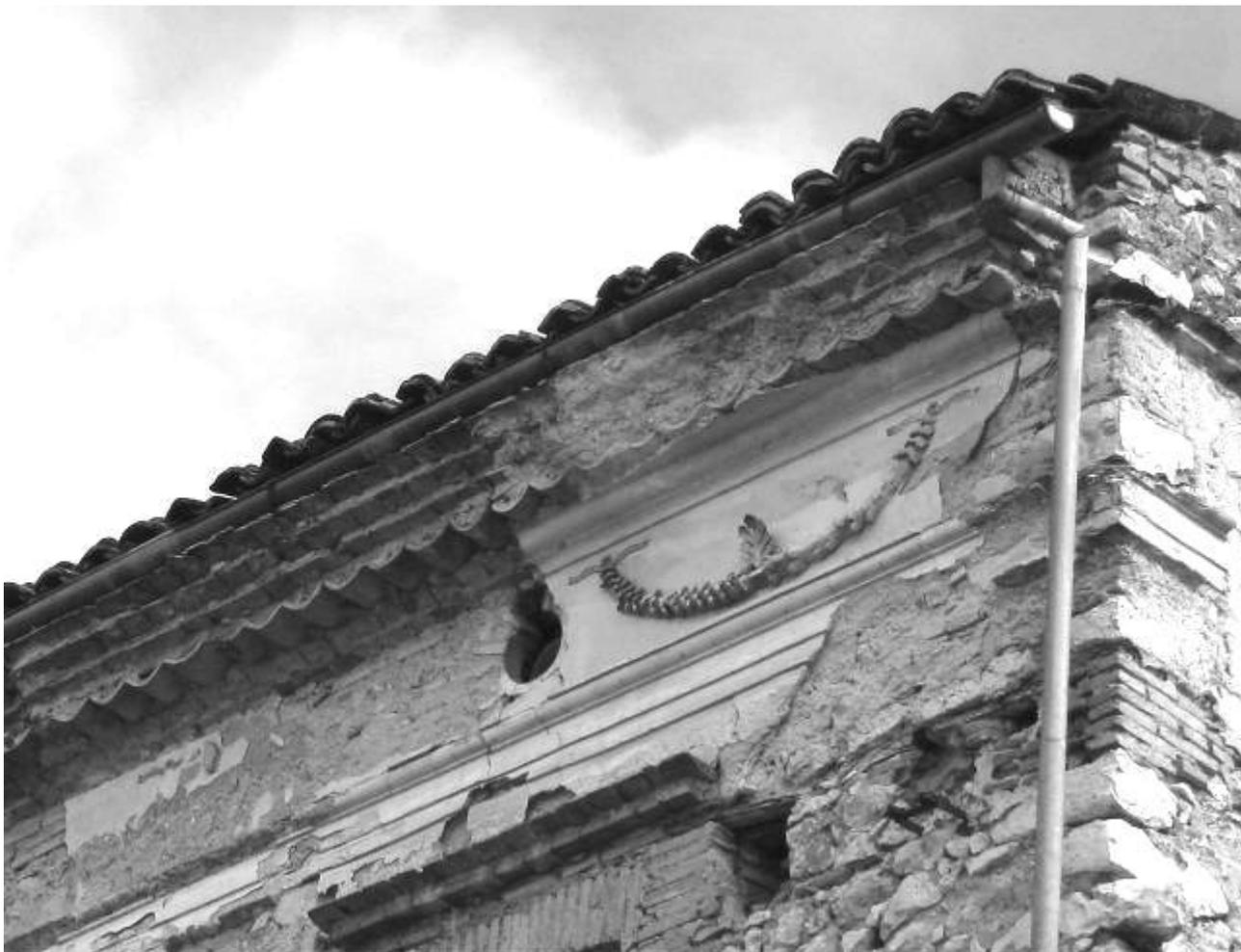
Fig. 270 – Cornicione di un palazzo di Scurcola. Scheletro in laterizi e avanzi della decorazione in stucco
