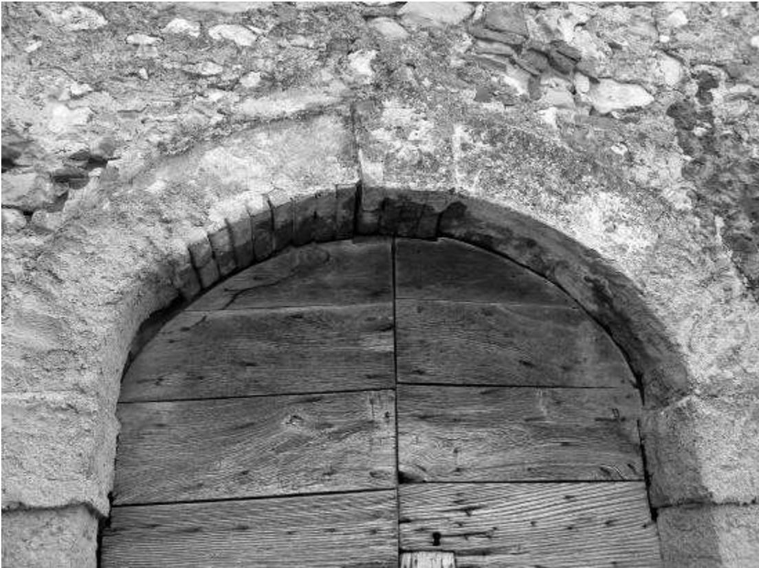
Fig. 288 – Poggetello. Portale di una casa con mostra in mattoni, rivestita d'intonaco a imitazione della pietra
