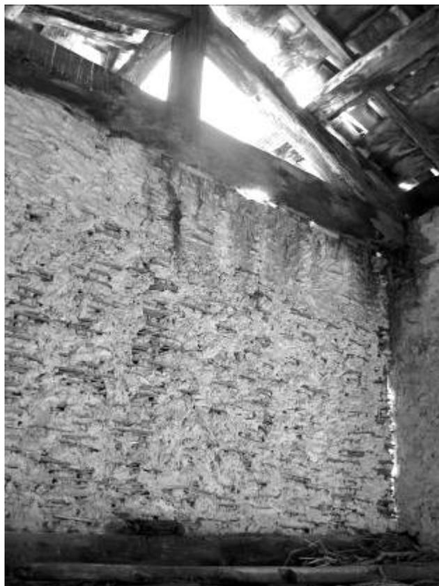
Fig. 272 – Casale a Fonte Scodella (Sante Marie). *Fratticcio* al piano superiore, impostato sulle travature del solaio. I pali del telaio interno sono inchiodati in basso alla trave che corre alla base del muro, in alto alla catena della capriata
