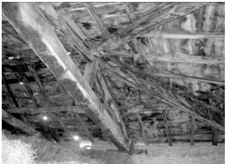
Fig. 269 – Boccalve (Sante Marie). Stalla-fienile. Travature del tetto a quattro pioventi
