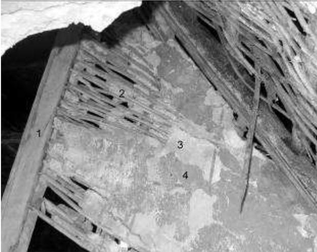
Fig. 274 – Sante Marie. Controsoffitto in giacitura secondaria all'interno di un edificio abbandonato sul crinale delle Serre. 1. Traverso del telaio; 2. Rami di nocciolo intrecciati; 3. Intonaco di calce; 4. Pittura
