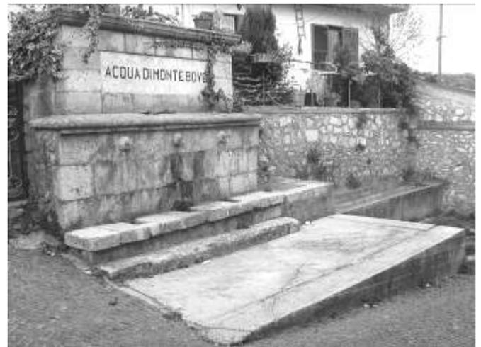
Fig. 247 – Sante Marie. Fontana delle Tre Cannelle, con le cavità per le conche sotto le cannelle e abbeveratoio laterale
