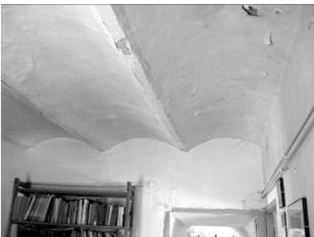
Fig. 276 – Poggetello. Palazzetto Del Grosso Colonna. Controsoffitto all'ultimo piano con volte impostate su travi
