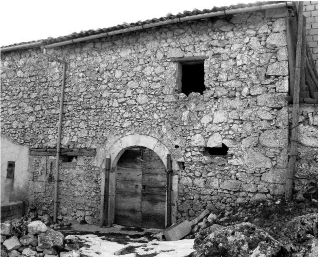
Fig. 253 – Tremonti. Muratura irregolare di una vecchia stalla-fienile con corsi di orizzontamento
