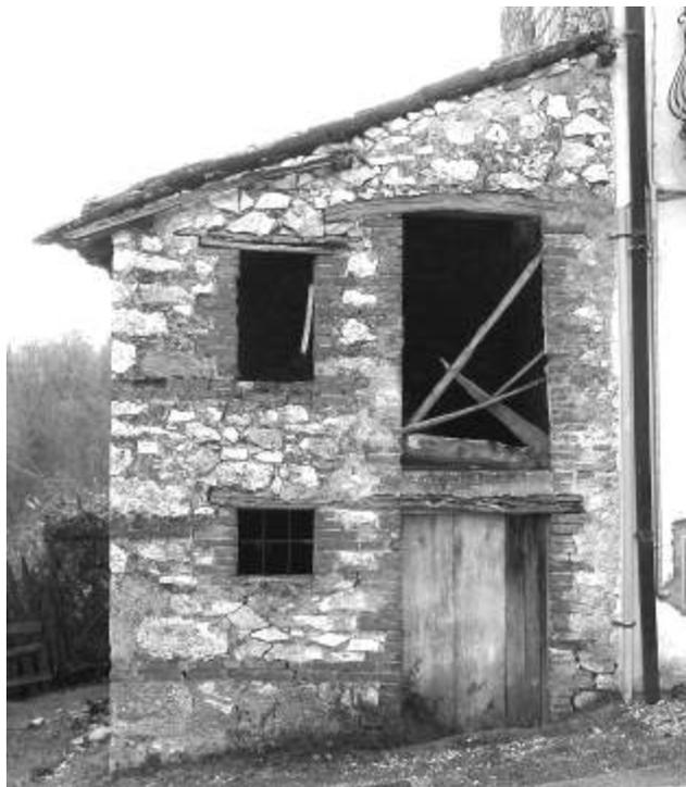
Fig. 262 – Poggetello. Stalla-fienile del 1916 con catene di laterizi
