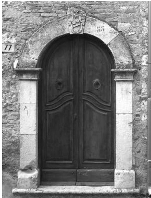
Fig. 283 – Scanzano. Portale con capitelli tuscanici e basi a dado provviste di una modanatura di raccordo sotto gli stipiti
