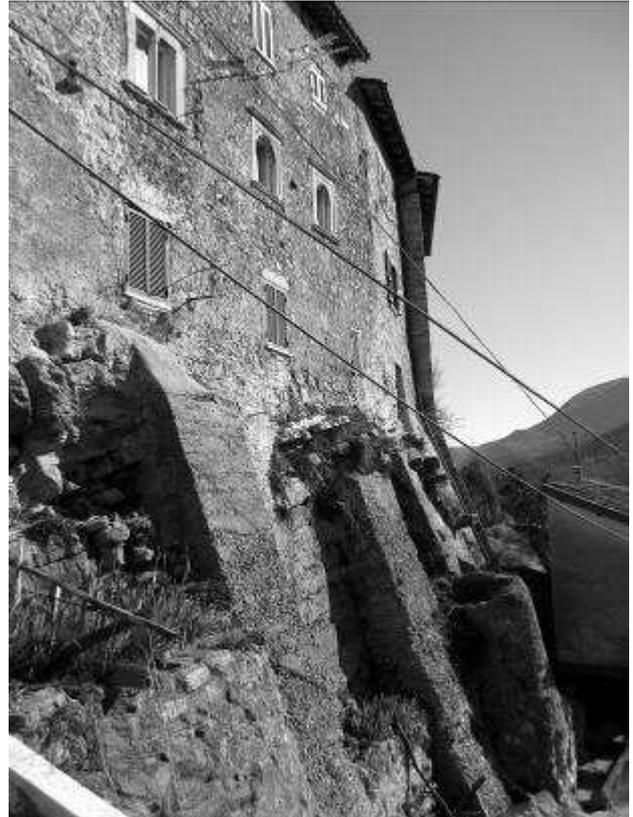
Fig. 133 – Carsoli. Rocce e muri di sostruzione con contrafforti alla base delle case-mura
