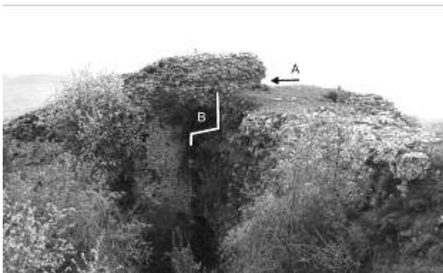
Fig. 93 – Castello di Tagliacozzo. Il cortile interno visto dal muro O. Sullo sfondo il muro perimetrale dell'ambiente posto nella torre SE. A. Incasso longitudinale di una catena lignea; B. Risega nella parte interna del muro S
