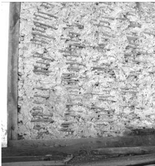
Fig. 273 - Casale a Fonte Scodella (Sante Marie). *Fratticcio* al piano superiore. Particolare della struttura
