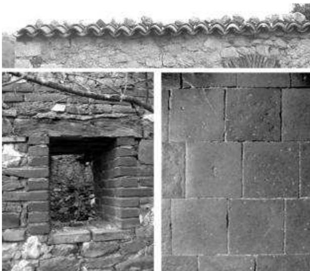
Fig. 302 – Tipi di laterizi prodotti a Poggetello: *canali* (in alto); *mazzocchi* (in basso a sinistra); *quadri* (in basso a destra)
