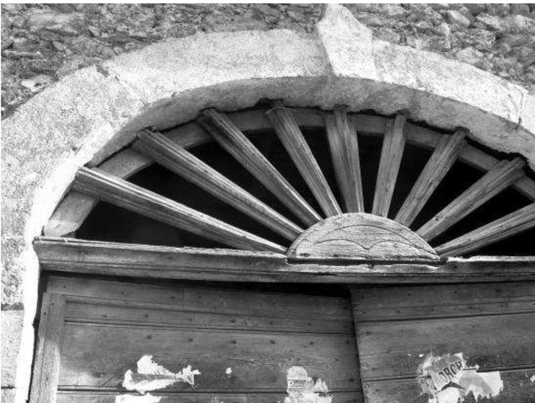
Fig. 289 – Santo Stefano. Sopraluce a raggiera di legno. Le teste dei raggi sono inchiodate a un telaio curvilineo posto dietro i conci dell'arco e sono alloggiare entro apposite cavità tagliate nell'intradosso della mostra lapidea
