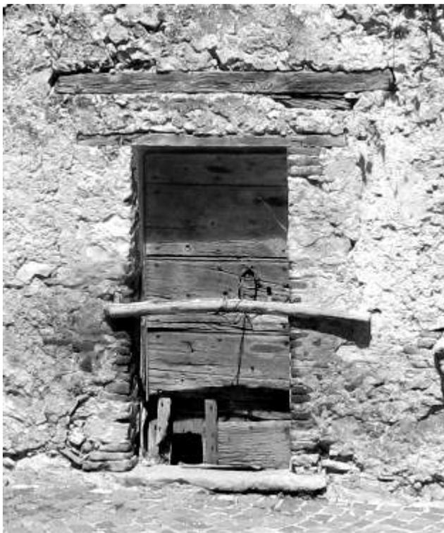
Fig. 279 – Edificio rustico a San Giovanni. Architrave di legno protetto da una trave di maggiore spessore inserita nella muratura soprastante
