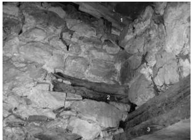
Fig. 261 – Sante Marie. Stalla di Mario Tesone. Particolare di alcuni elementi lignei visibili all'interno dell'edificio. 1. Trave del tetto; 2. Catena; 3. Architrave della porta
