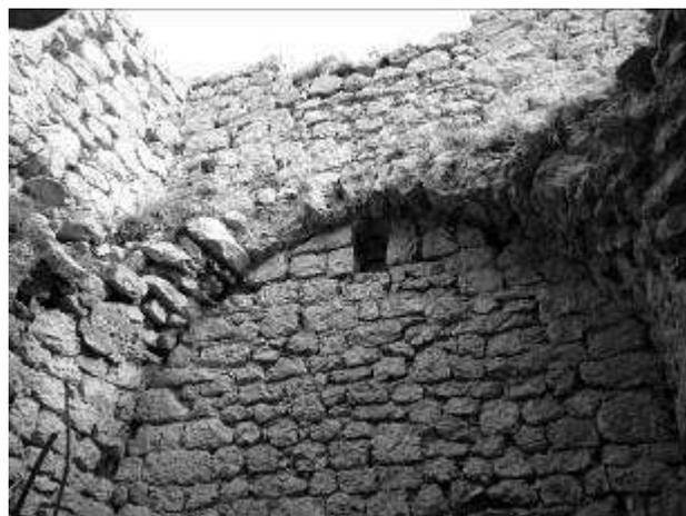
Fig. 82 – Castello di Tremonti. Veduta dell'interno con i resti della volta a botte che copriva l'ambiente al I livello
