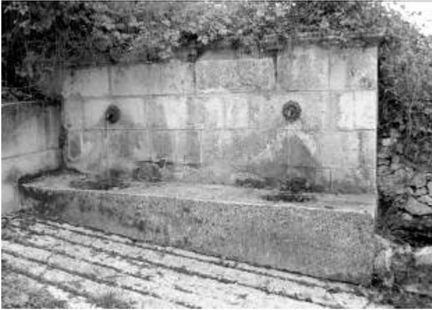
Fig. 249 – Poggetello. Fontana a muro in conci lapidei con due cavità per le conche
