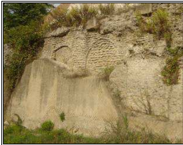
10. Particolare del muro di età augustea e del muro di età giulio-claudia
