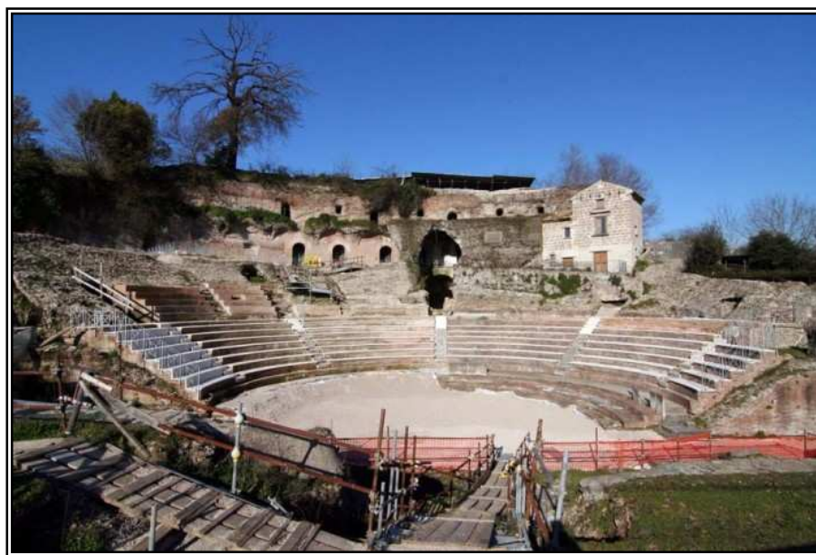
44. Veduta della cavea del teatro di Teano
