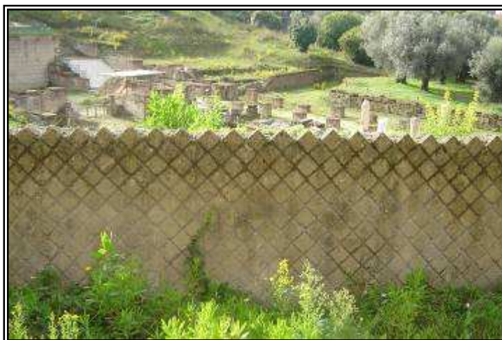
8. Particolare del muro di recinzione della media cavea collocato nella parte nord della summa cavea
