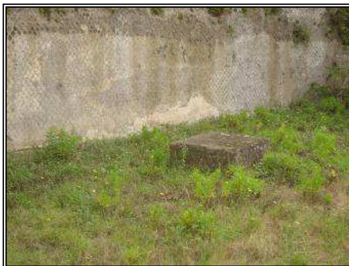
7. Particolare di una delle basi di pilastri collocate nella metà meridionale della summa cavea
