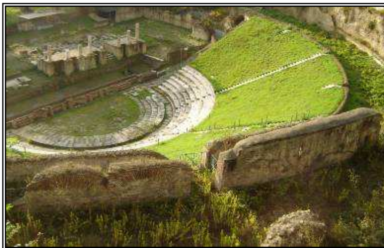
16. Particolare del muro con archi di scarico in bipedali
