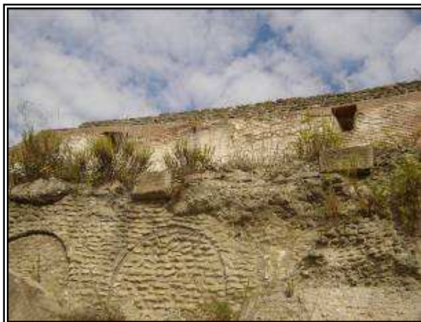
11. Particolare dei fori per il fissaggio dei pali del velarium
