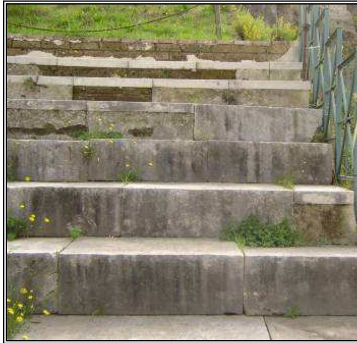
22. Parte meridionale della cavea in cui sono visibili sia i blocchi antichi che quelli di restauro
