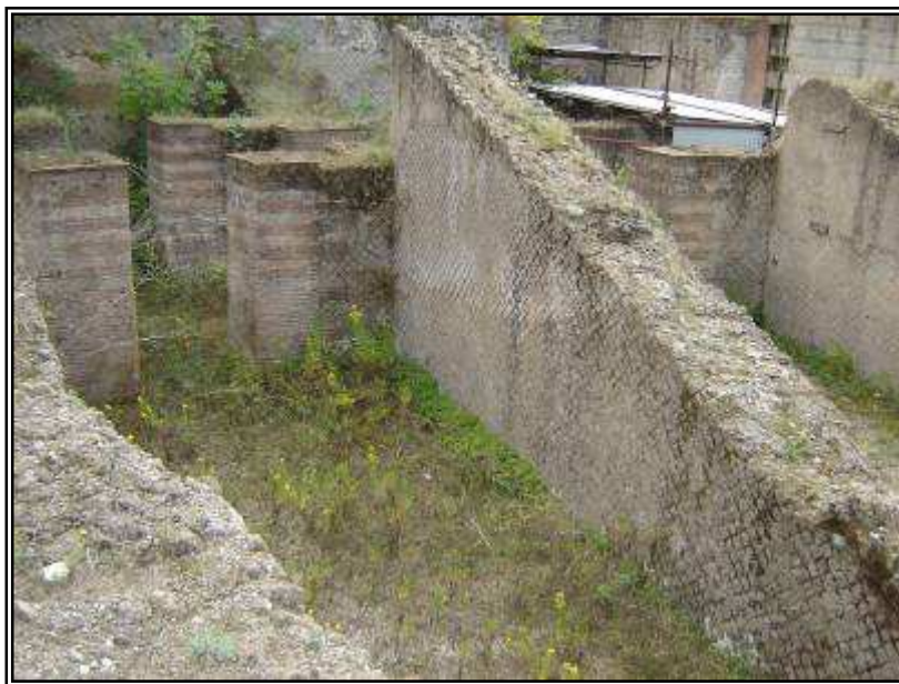
19. Camere ricavate nella parte sud della cavea
