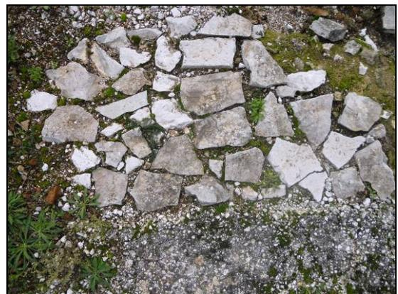
**Figura 76-77-78: pavimentazione in piccole lastre di calcare, foto di Alessandra Iodice.**
