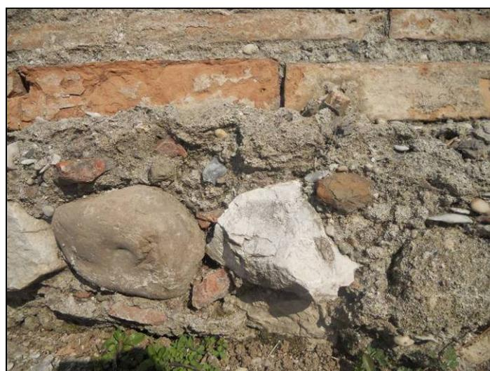
**Figura 51-52: particolari delle fondazioni del muro perimetrale nord, a sinistra cubilia in calcare allettati in una malta giallo-bruna; a destra rimaneggiamenti successivi caratterizzati da una malta grigia, foto di A. Iodice.**
