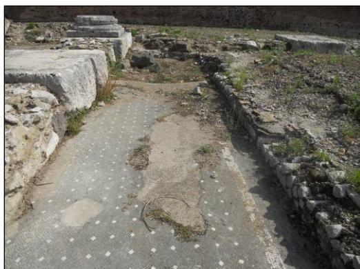
Conservatosi per una lunghezza di 16,30 metri, con uno spessore di 0,60 metri, è realizzato con cubilia, in pietra calcarea, di dimensioni variabili (da 0,09 a 0,11 m), con la faccia a vista intonacata, di cui si sono rilevate delle tracce.
