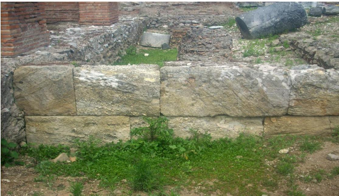
**Figura 4** Particolare blocchi di tufo (visibili i solchi di spianamento).
