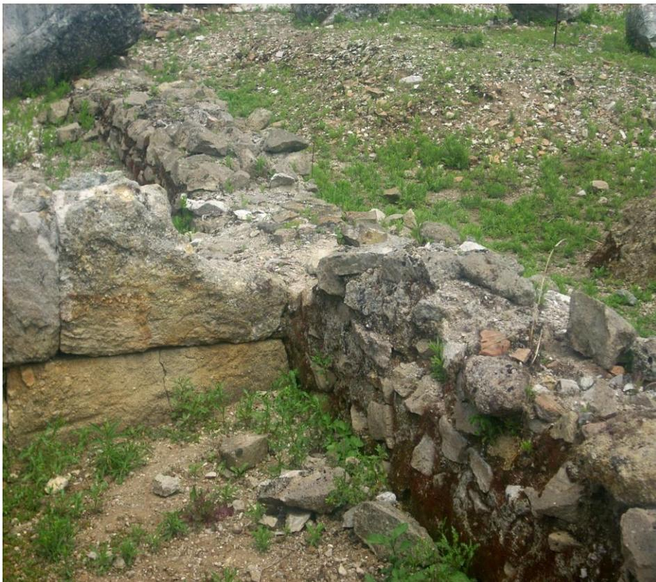
**Figura 8** Particolare del cementizio con pietrame in tufo.
