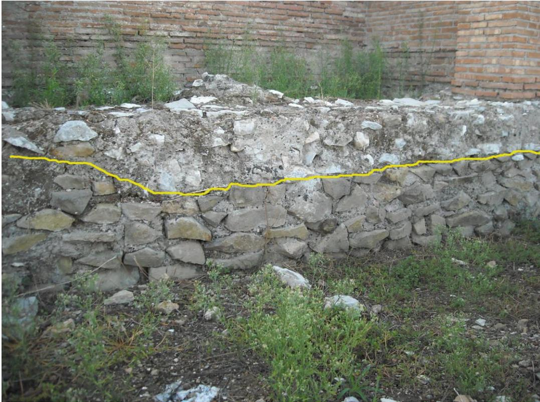
**Figura 5** Particolare dei due tipi di cementizio A e B
