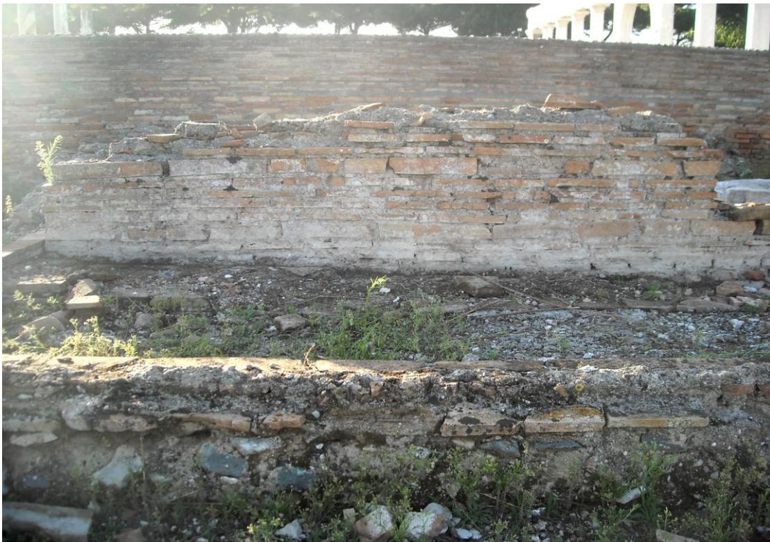
**Figura 18** Muro C3d costruito in tegole.
