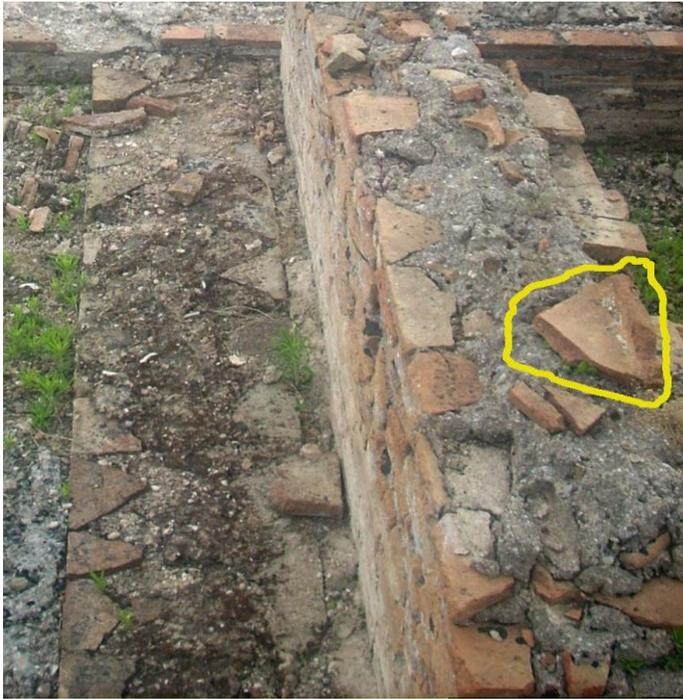
**Figura 19** Particolare delle tegole utilizzate per il muro C3d.
