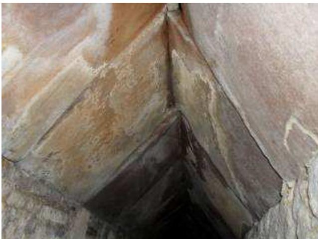
Foto 7: copertura del condotto (tetto di tegole)
