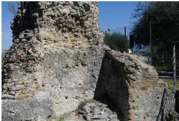
**Fig118;** *frigidarium*, parete a sud –est del *calidarium* particolare paramento in opera mista.
