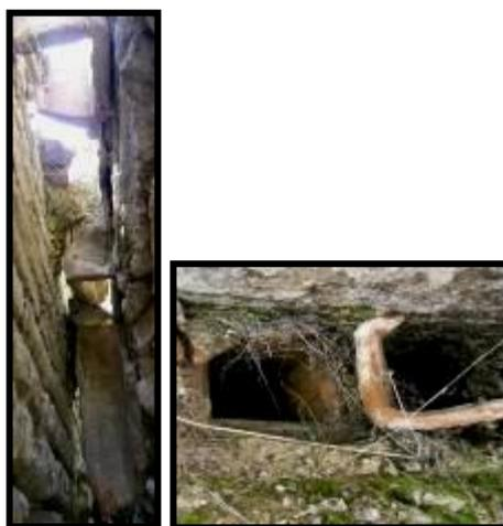
**Fig.97. Tubuli conservati nell'ambiente C, sul muro a est.**
