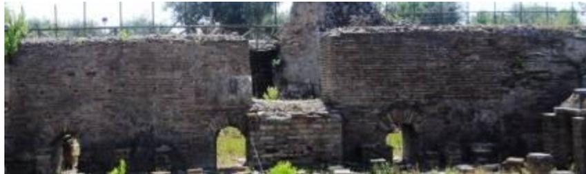
**Fig111; parete a est dell'ambiente A del *calidarium*, paramento in opera mista.**
