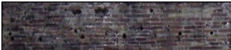
**Fig.98. Particolare del paramento del muro est, con i fori per le grappe.**
