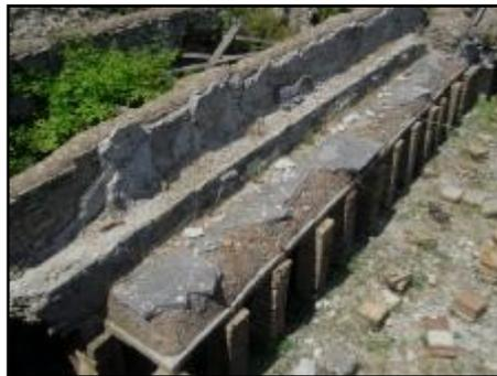
**Fig. 61. Particolare delle *suspensurae* viste dall'alto della parete est.**
