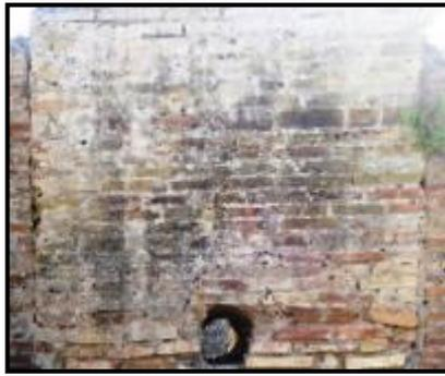
**Fig.83. Particolare del paramento dell'USM3, sulla parete est, con *testae* con caratteristiche diverse.**
