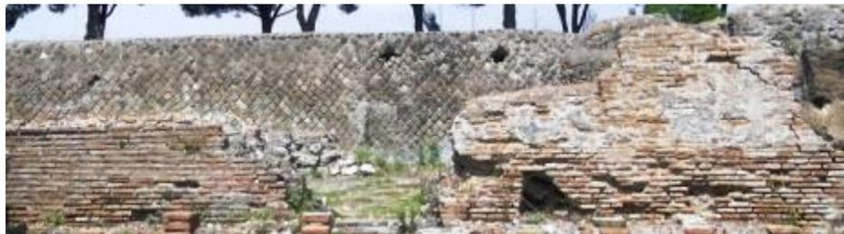
**Fig112. Parete Ovest dell'ambiente A, paramento interno in opera mista.**
