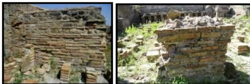
**Fig.74 -75. Particolari del muro in opera mista sul lato N dell'ambiente**
