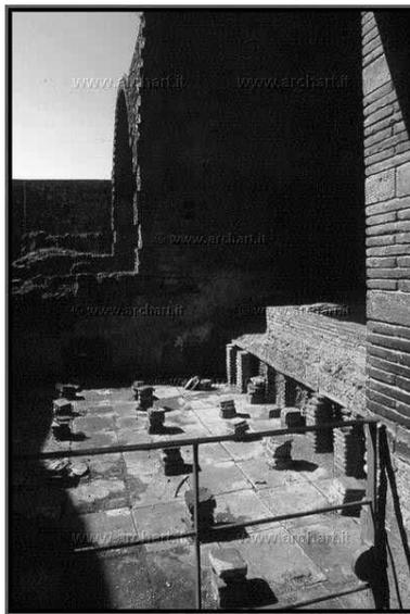
**Fig.24. Pompei, Terme Stabiane. Sono visibili pilastri di mattoni quadrati legati con spessi strati di malta.**
