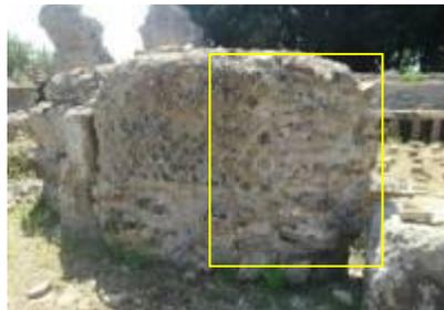
**Fig116; tratto di muro a Nord-est dell'ambiente absidato B, particolare del paramento esterno in opera mista sull'USM6, con ammorsature laterali ( in giallo).**
