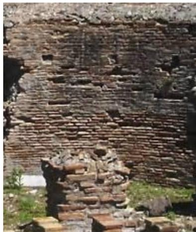
**Fig115. Parete semicircolare dell'ambiente B, paramento in *opus testaceum*. USM8.**
