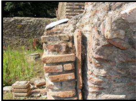
**Fig.48. Apertura sulla parete E, particolare del muro di rinforzo aggettante verso il lato del *tepidarium* e che aggetta anche verso il *calidarium*.**
