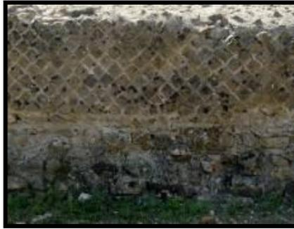
**Fig.88. Parete a Nord dell'ambiente B, particolare del paramento in *opus reticulatum* e fondazioni.**
