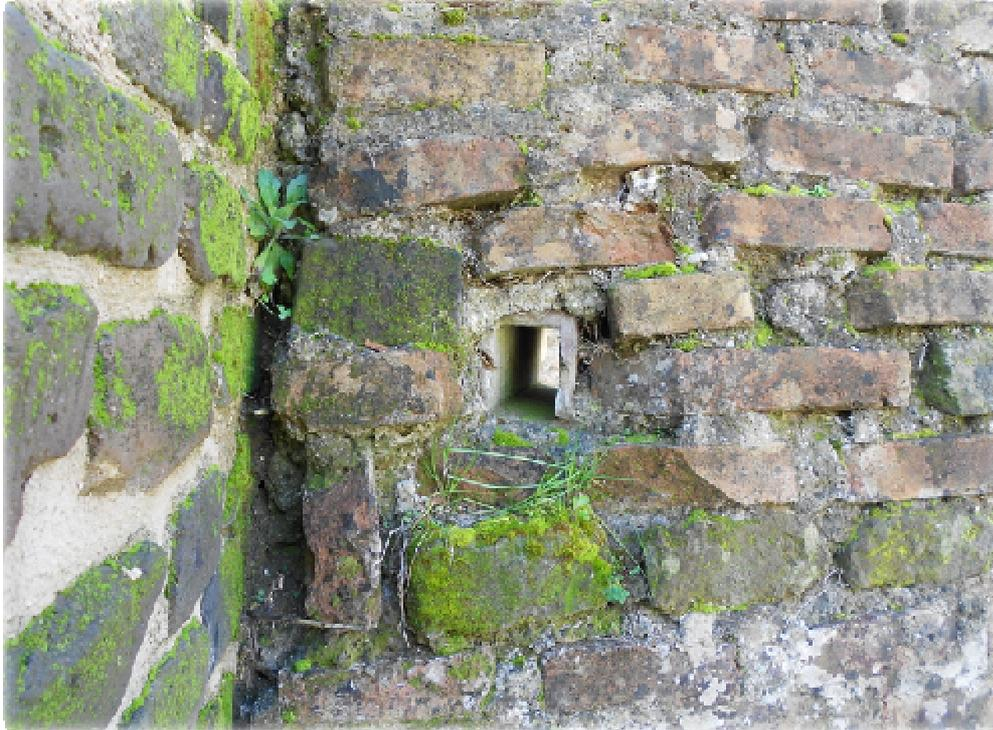
*Fig. 5 Terme di Treglia. Fori rettangolari per lo sfiato dei vapori lungo le pareti del vano V4.*
