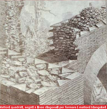
Mattoni quadrati, tagliati a linee diagonali per formare i mattoni triangolari delle Antichità romane (1756), Il volume - G.B. Piranesi
